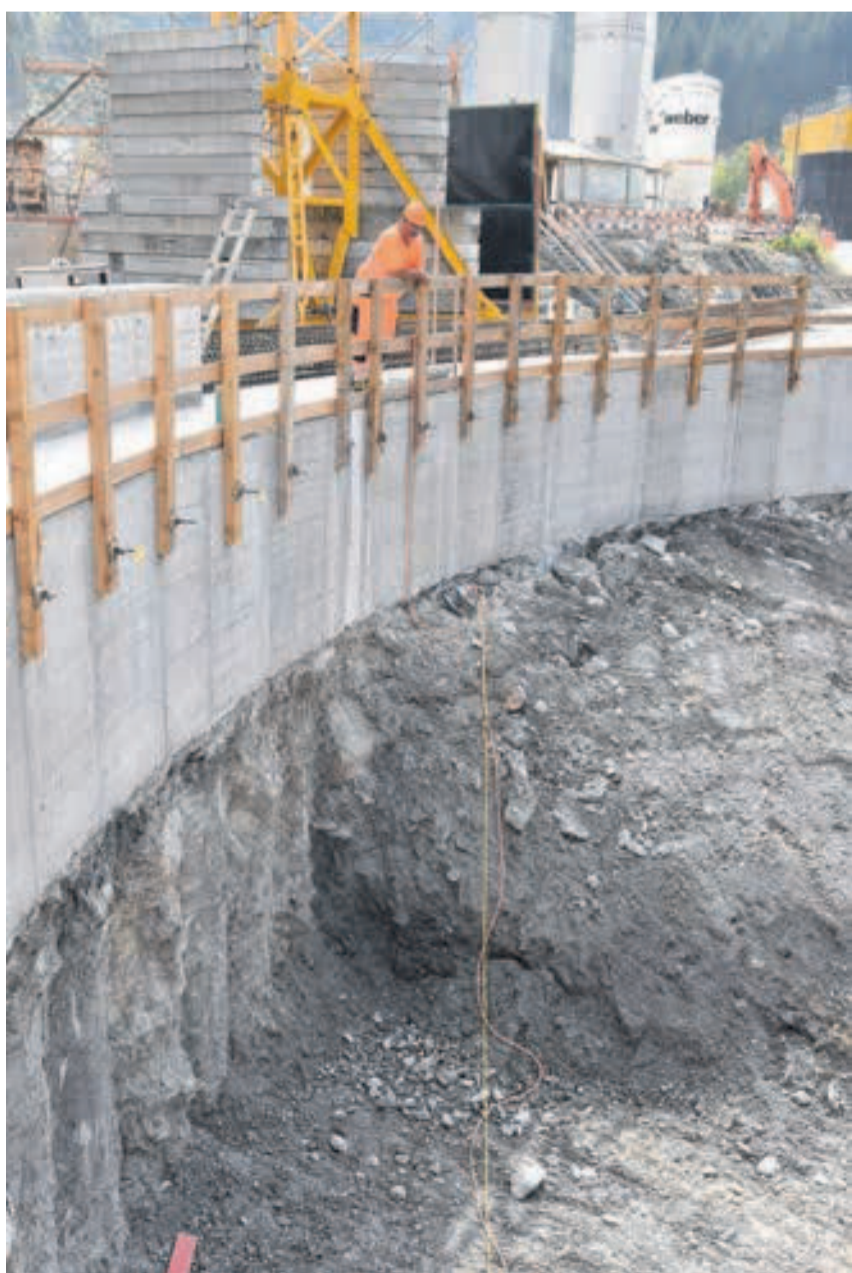
Der Blick hinunter auf die Pfahlwand, die künftig das Nordportal sichert.
