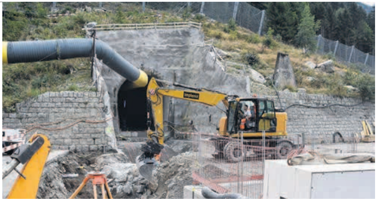
Vorbereitungsarbeiten am Eingang des Förderbandstollens, über den die Betonfabrik versorgt wird, die im Innern des Berges erstellt wird.
