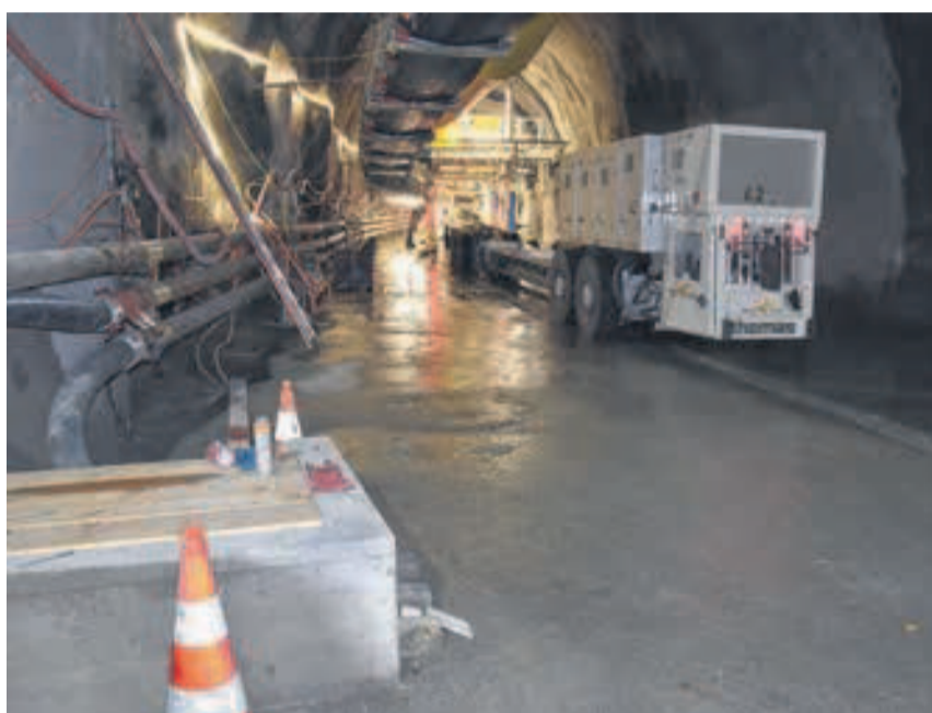
Fortlaufend werden Betonelemente in den ausgebrochenen Tunnel gefahren.
