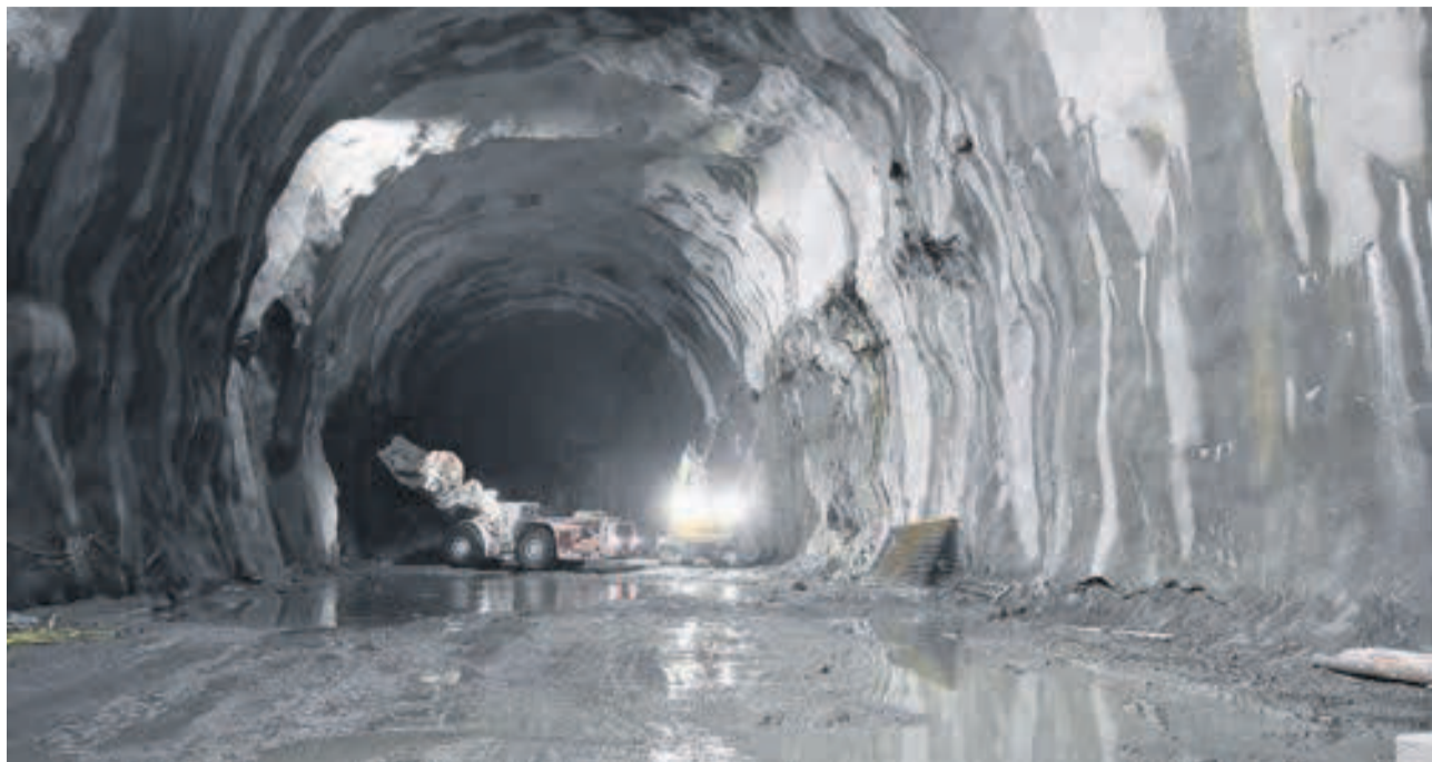
Der «Toro» lädt auf: Dieses Gefährt transportiert sieben Kubikmeter Gestein auf einmal.
