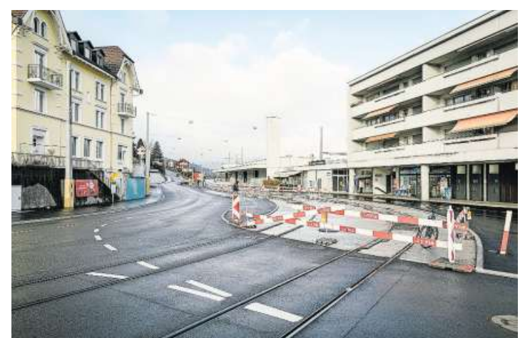
«Endstation, bitte alle aussteigen!»: Beim Bahnhof Killwangen-Spreitenbach sind die Gleise schon verlegt, aber mit den letzten Arbeiten wird wegen Vandalen noch zugewartet. Bilder: Valentin Hehli (7. Dezember 2021)
