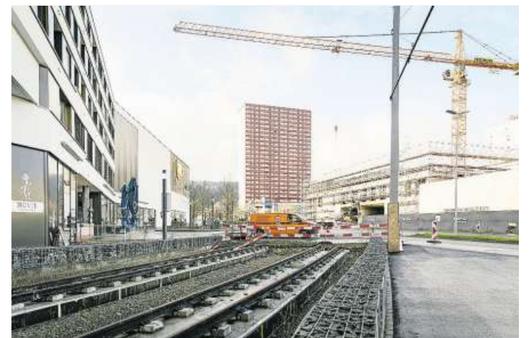
Hier beim Limmatspot in Spreitenbach enden die verlegten Gleise. Auf der Sandäckerstrasse zwischen Limmatspot und der Baustelle des Tivoli Garten kommen die Gleise erst noch.
