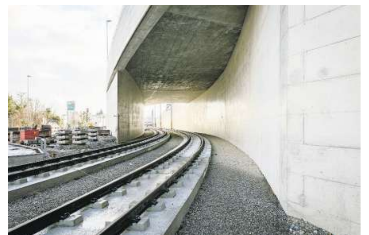
Das Rampenbauwerk kurz vor dem Bahnhof Killwangen-Spreitenbach und nahe an der Grenze von Spreitenbach und Killwangen ist sozusagen auch ein ganz kurzer Tunnel.
