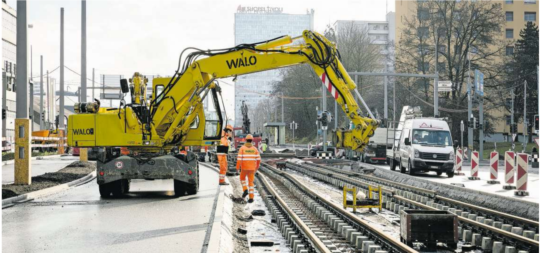
Ein Grossteil der Gleise für die Limmattalbahnhof ist bereits gelegt, so wie hier an der Landstrasse in Spreitenbach. Beim Shoppi Tivoli (hinten) stehen noch grössere Arbeiten an.
